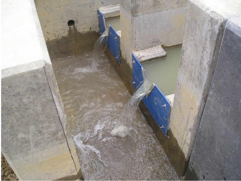
Caudal del filtro de drenaje con nivel máximo - Presa Yana
